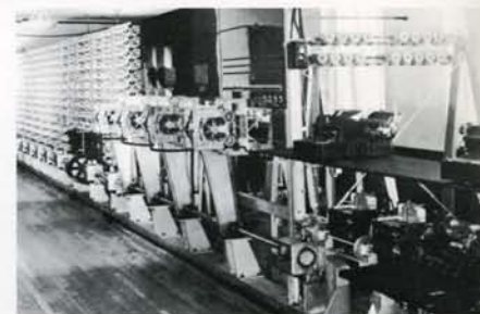
L'Automatic Sequence Controlled Calculator (Harvard Mark I) fu il più grande calcolatore elettromeccanico mai costruito. Progettato da Howard Aiken della Harvard University, il Mark I venne realizzato dai tecnici IBM a Endicott (N.Y.) e successivamente installato a Harvard nel 1944.
